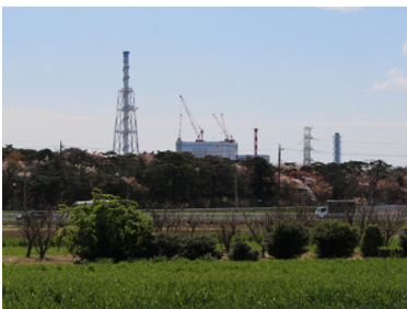
防潮堤の建設など再稼働に向けた工事が進められている東海第2原発
