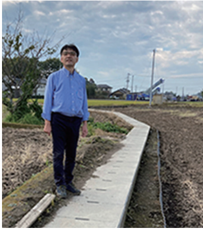
▲近くの排水路整備も要望中
