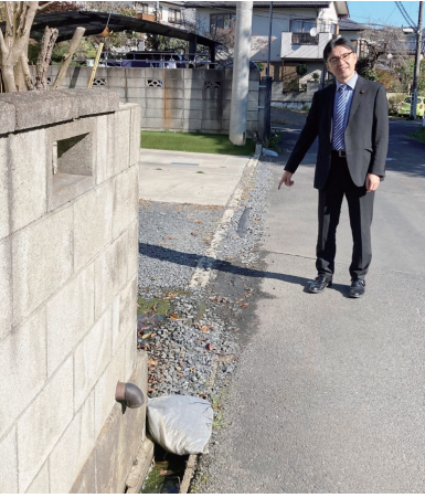
▲間もなく工事が始まります
