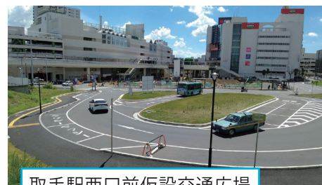
取手駅西口前仮設交通広場
