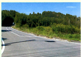
市道12号線道路修繕
