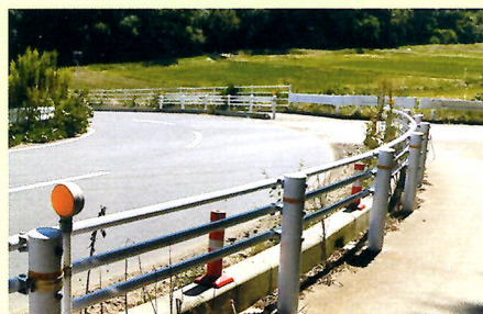
ガードパイプ設置
