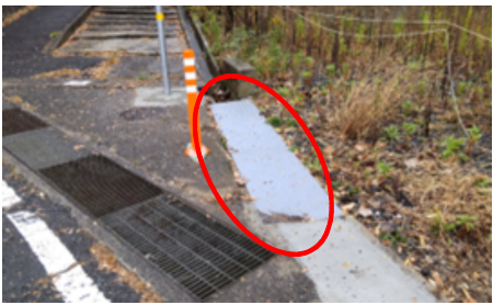
水木小通学路の側溝フタ設置 (水木町)
