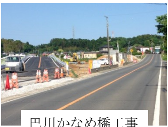
巴川かなめ橋工事
