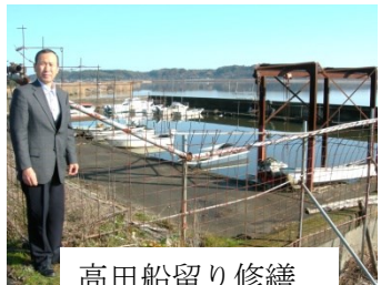
高田船留り修繕
