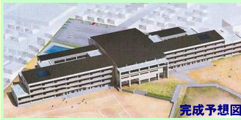
見川小・中学校・幼稚園が改築へ なかにわ議員は老朽化した見川小・中学校・幼稚園の改築を市議会でも15回も主張し、2014年度から見川中学校の改築工事がはじまりました。
