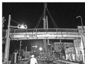
夜間に重機で撤去中の青柳歩道橋(岩瀬庁舎前)
