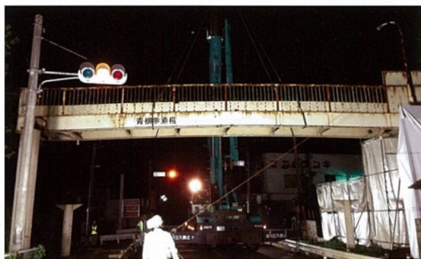
2013年8月撤去工事(上の写真)
