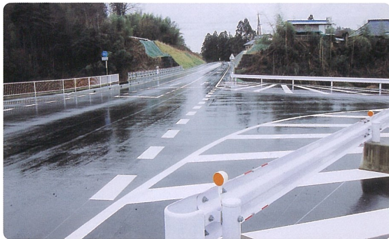
開通した小町橋(2013年11月19日・堀江撮影)
